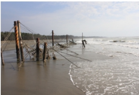
圖五 第三座海岸柔性攔截網施作後海灘淤砂情形(2011/09/26)
