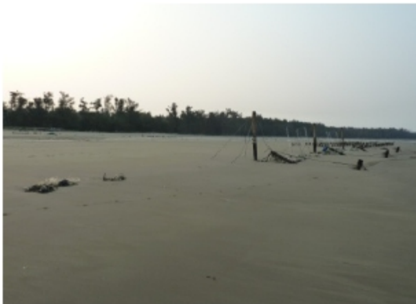
圖四 第二座海岸柔性攔截網施作後海灘淤砂情形(2011/10/30)
